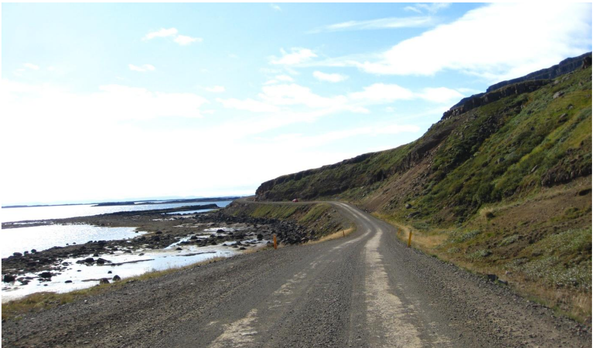
Mynd 27. Hamar, Kirkjubólslif, á milli stöðva 5500-5600. Skorið verður af hamrinum auk þess sem fyllingar verða settar niður í fjöruna á um 90m kafla þar sem hún kemur mest inn (sjá þrívíddarmynd 13).
